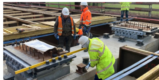
Einbau der Lager an der ersten neuen Leverkusener Teilbrücke.
