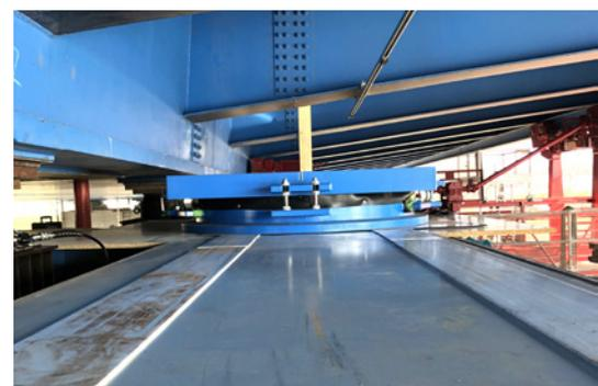
Die neuen Lager wurden über eine temporäre Verschiebbahn an Ort und Stelle gebracht.
