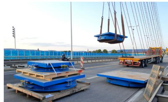
Die neuen Kalottenlager wurden von der Brückenoberseite aus ausgetauscht.
