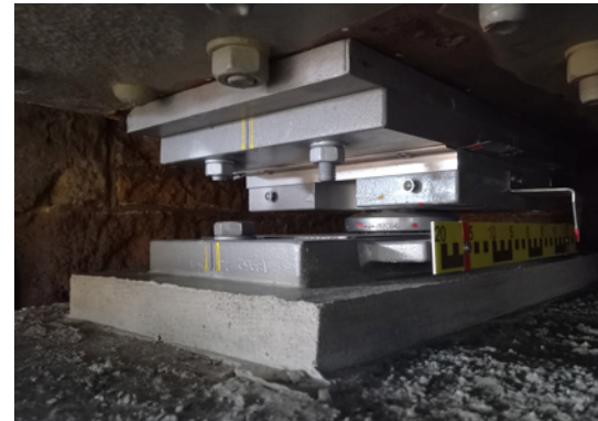
Mehr Platz gab es nicht: Extrem enge Raumsituation an einem Lager unter einem Stahlträger ...
