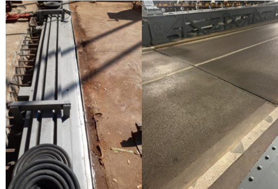
Einbau einer Dehnfuge an den sanierten Brückenden – rechts eine eingebaute Dehnfuge.
