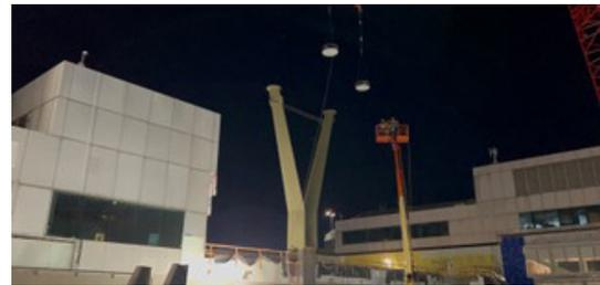
Montage der SIP-Lager auf die Y-Säulen. Die Arbeiten wurden nachts durchgeführt, da der Flughafen bei laufendem Betrieb renoviert wird.
