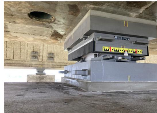
Eines der 24 neu eingebauten Kalottensegmentlager.
