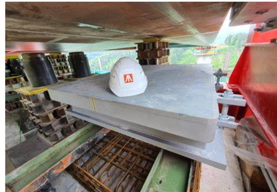
Lager an Ort und Stelle vor dem Einbetonieren.
