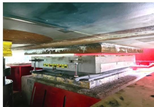
Einbetoniertes Lager vor dem Absenken der Brücke.
