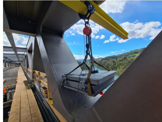
Einhub der SIP®-Lager über spezielle Rüstträger.
