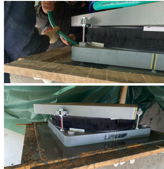
Präzises Einbetonieren der SIP®-V-Lager. Bürsten schützen den empfindlichen Lagerkern (Puck) vor Staub.
