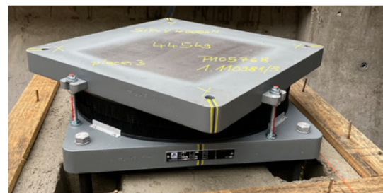
Einschwenken und Positionieren eines SIP®-V-Lagers zum Schutz des Gebäudekerns.
