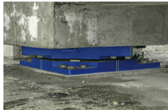
Eingebautes SIP®-D-Lager unter einem Pfeiler des Yarumo-blanco-Viadukts in Kolumbien.
