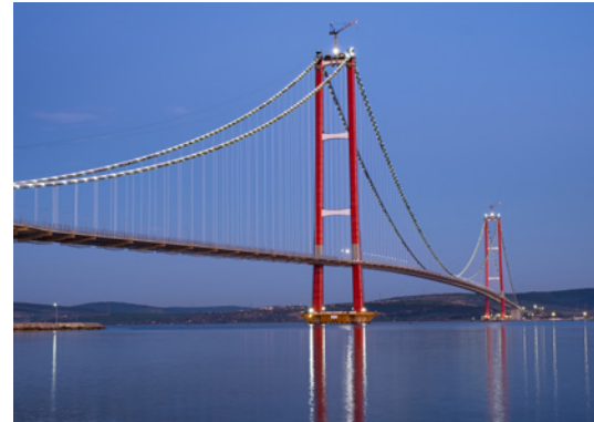
Die längste Hängebrücke der Welt, die 1915Çanakkale über die Dardanellen, hat eine Hauptspannweite von 2.023 m.
