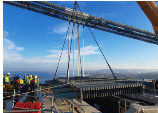
Die MSM® Schwenktraversen-Dehnfuge beim Einbau in die Brücke.
