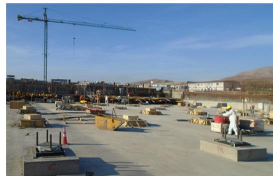
Fundament des Klinikzentrums in Alto Hospicio 2019: Auf den Betonsöckeln liegen die ersten SIP®-D-Lager.
