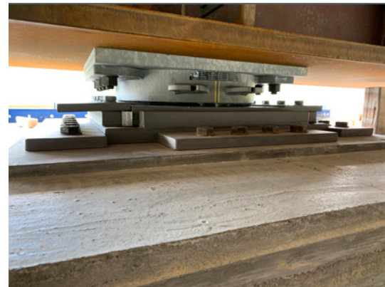
Eingebautes Lager mit aufgelegtem Stahlträger.
