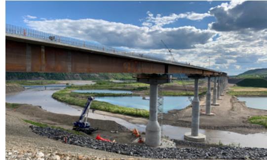
Die Halfway River Bridge im Bau, Mai 2021. Die konischen Pfeiler signalisieren die künftige Wasseroberfläche des Stausees.
