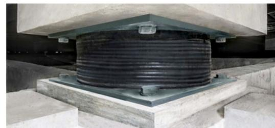
Eines der 243 Bleikernlager zwischen der oberen Betonplattform und der unteren Betonwanne. Gut zu sehen die ringförmigen Verformungen des Elastomers aufgrund der Elastomer-Stahlblech-Schichtung.
