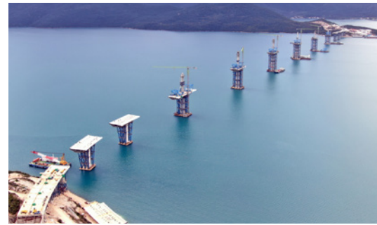
September 2020: Blick hinüber zur Halbinsel Pelješac. 2022 soll die Brücke eingeweiht werden.
