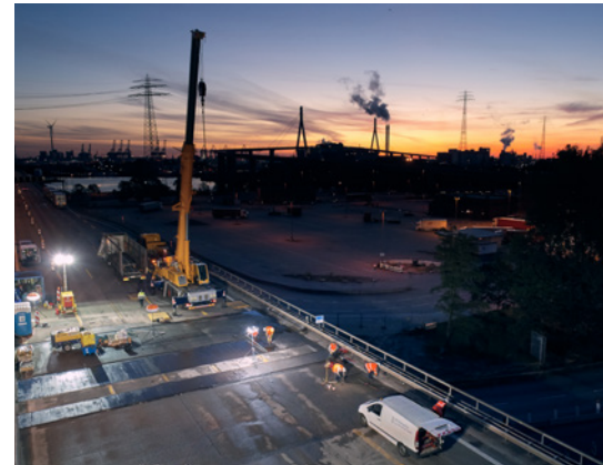
Gearbeitet wurde im Drei-Schicht-Betrieb 55 Stunden lang rund um die Uhr.
