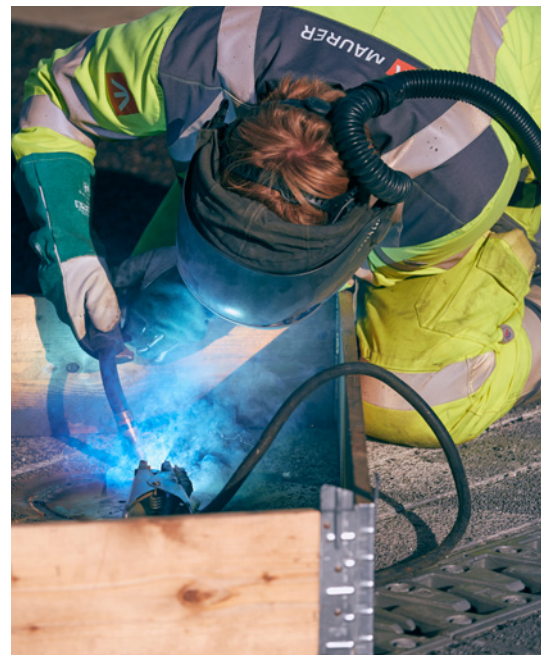
Detailarbeit. Rechts vorne zu sehen: der im Mega-MMBS integrierte Fahrbahnübergang.
