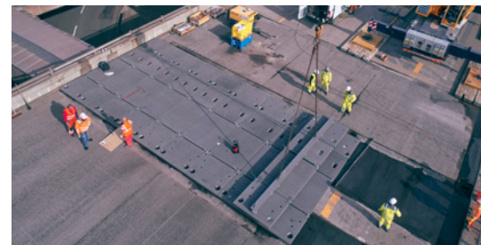
Einhub einer Mega-MMBS mit einem 100-t-Kran.
