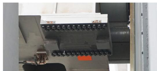
Das Oberteil des längsfesten Horizontalkraftlagers bei geöffneter Hubbrücke: Zu sehen sind die beiden „Zähne“, die das Einfädeln in Längsrichtung sichern und Längskräfte übertragen.
