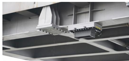
Untersicht auf die geöffnete neue Bahn-Hubbrücke, links die Auflagerfläche für das allseits bewegliche Verformungslager, rechts das Oberteil zum Einfädeln in das querfeste Horizontalkraftlager.
