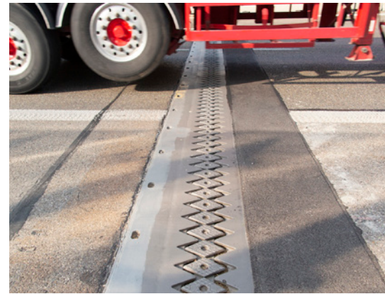
Der neue Fahrbahnübergang unter Verkehr.
