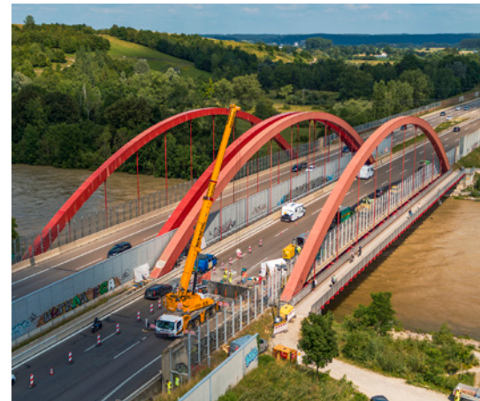
Die Lechbrücke bei Gersthofen, westlich von Augsburg, während der Fugentausch-Baustelle. Der gesamte Tausch dauerte nur ein Wochenende, mit nur fünfzehn Stunden Vollsperrung.
