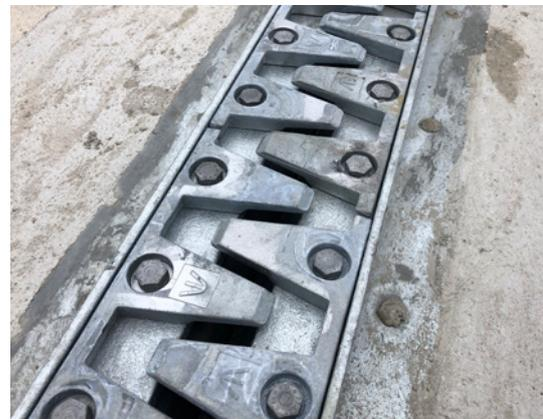
Einbetonierte XC1 Dehnfuge in Oosterhout im Süden der Niederlande. Auf der Oberseite sind die M-Plates sichtbar.
