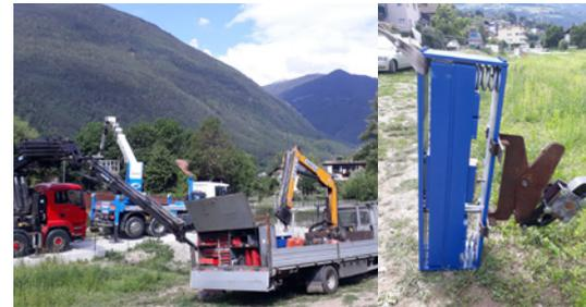
Links: Die zwei Kranwagen im Hintergrund waren dafür zuständig, jeweils einen Montagekorb und einen Dämpfer unter die Brücke zu hieven. Rechts: Der Dämpfer ist abgeladen und hier beweist sich der Kasten rund um Masse und Spiralfeder: Trotz der 90°-Drehung nimmt das Dämpfersystem keinen Schaden.
