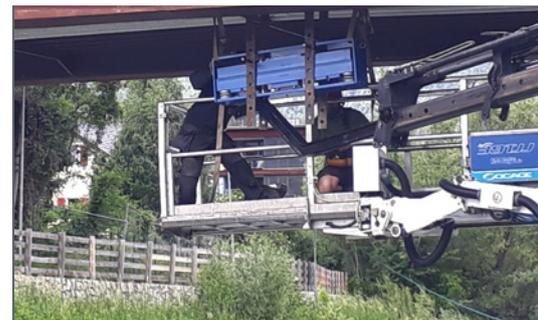
Als Hilfe, um den Dämpfer an Ort und Stelle zu bringen, sind vier Lochbleche vertikal angeschweißt. Der Kran drückt die Dämpfer Loch für Loch nach oben, abwechselnd rechts und links, die Steckstangen sichern die jeweilige Position.
