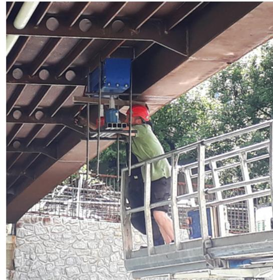
Für die Feinjustierung des Dämpfers kommen Hydraulikpressen zum Einsatz, damit die vorgebohrten Löcher millimetergenau aufeinander passen.
