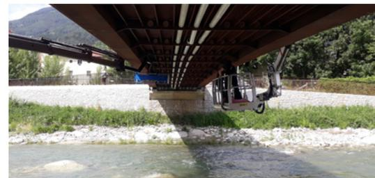
Von zwei Seiten bedienen die Kranausleger die Montagestelle in der Mitte der Brücke: Links der Dämpfer, rechts die Monteure im Korb.
