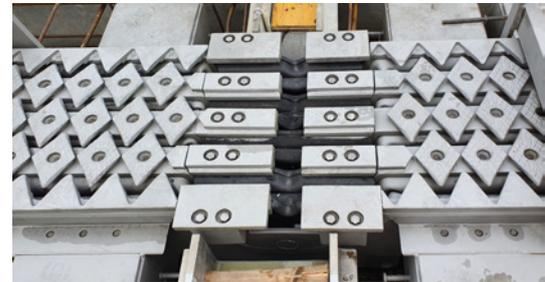
Schienendurchführung der geräuschgeminderten XL400 auf der Baustelle in Göteborg: In der Foto-mitte die Passtücke, zwischen denen die Schiene liegen wird.
