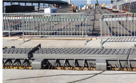
Die eingehobene Dehnfuge mit der Hebebrücke im Hintergrund. Links die bisherige, höhere Brücke.
