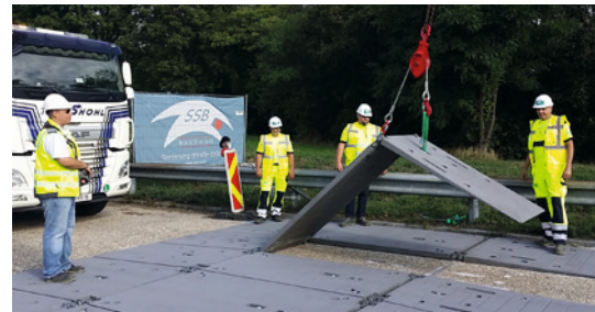
Prüfende Blicke beim Funktionstest eines MMBS-Elements.
