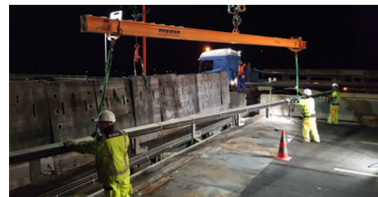
Einhub des 2. Mittelträgerpaares vor der ‚Wand‘ der geöffneten MMBS-Elemente. Keine 10 Minuten später rollte hier auf einer Spur der Verkehr wieder.
