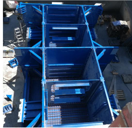
Blick von der Turmspitze in die Kammern der Stahlbox. Am Boden erkennbar die Stahlbewehrung des Betons: 220 t wurden insgesamt eingefüllt.
