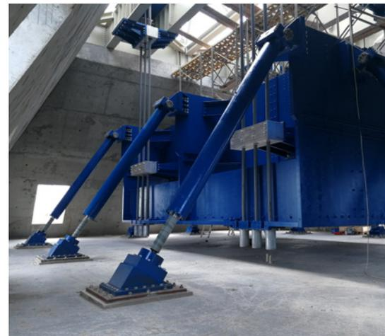
Der komplette TMD (Tuned Mass Damper) mit diagonal angedockten Hydraulikdämpfern, die bei Erdbeben die Amplitude auf 1,3 m begrenzen. Die jeweils drei Pendelseile an den vier Aufhängepunkten sind als vollverschlossene Seile mit glatter Oberfläche ausgeführt.
