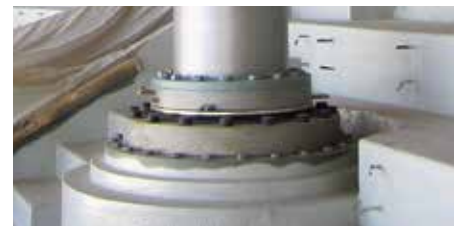
Eines von 11 Zug-Druck-Lagern
