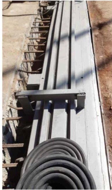
Einbau einer Dehnfuge an den sanierten Brückennenden. Foto: MAURER
