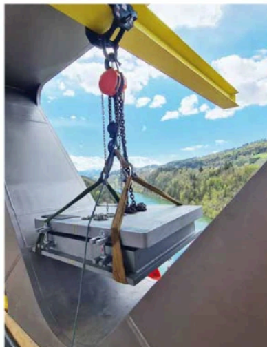
Einhub der SIP*-Lager über spezielle Rüstträger. Foto: MAURER
