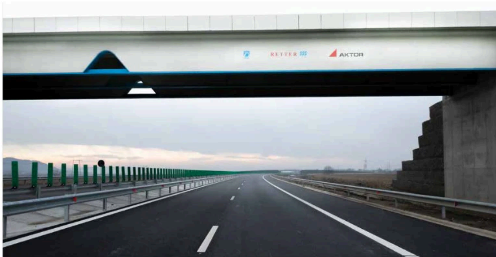
Autobahn A 7 Ploiesti-Buzau, komplette Ausführung inkl. mehrerer Brücken mit MAURER LRBs und modularen Dehnfugen.
