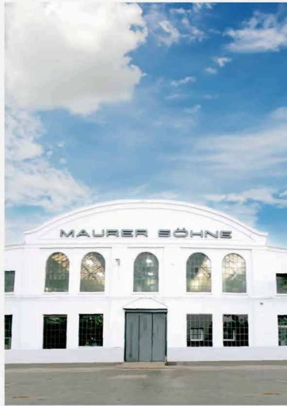
Denkmalgeschützte Fassade der Werkshalle 1, MAURER SE am Frankfurter Ring in München
