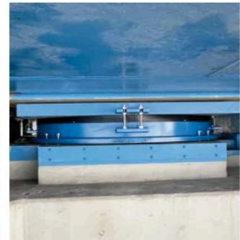
Die neuen Kalottenlager wurden von der Brückenseite aus ausgetauscht. Rechts: Eingebautes neues Kalottenlager. Fotos: MAURER
