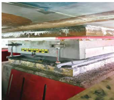
Einbetoniertes Lager vor dem Absenken der Brücke. Foto: MAURER
