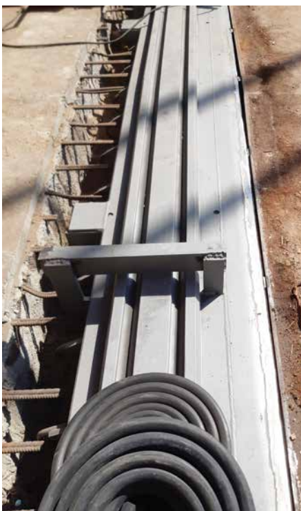
Einbau einer Dehnfuge an den sanierten Brückeneenden. Foto: MAURER
