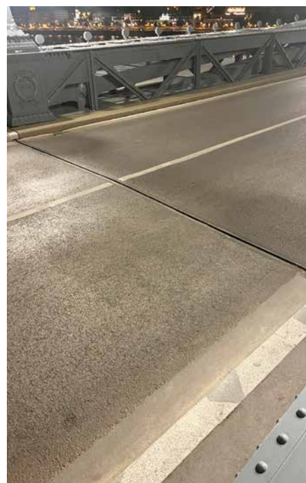
Eine eingebaute Dehnfuge. Foto: MAURER
