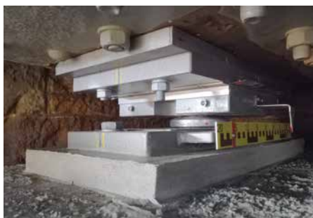
Mehr Platz gab es nicht: Extrem enge Raumsituation an einem Lager unter einem Stahlträger Foto: MAURER
