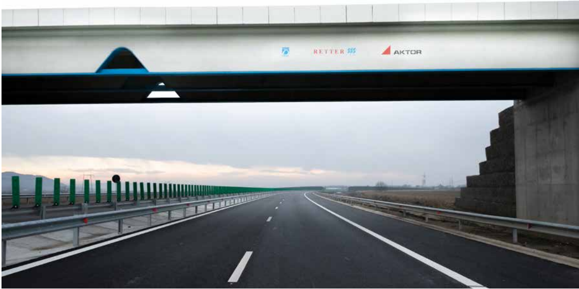
Autobahn A 7 Ploiesti-Buzau, komplette Ausführung inkl. mehrerer Brücken mit MAURER LRBs und modularen Dehnfugen.
