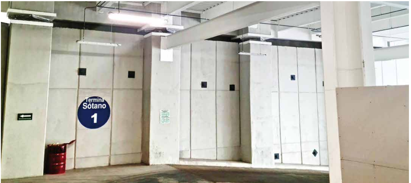
Vier der insgesamt 34 eingebauten SIP®-A-Lager oben auf den Stützsäulen. Unten sichtbar die Abfahrt zum unterirdischen Parkhaus. Foto: MAURER
