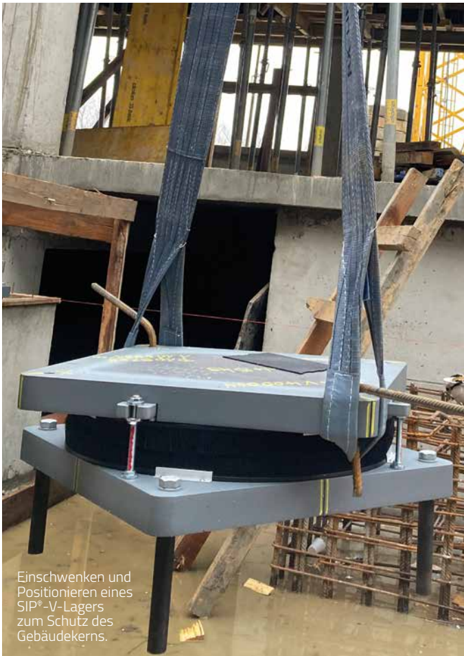
Einer der vier Hydraulikdämpfer zum Kippchutz des schmalen Gebäudekerns
