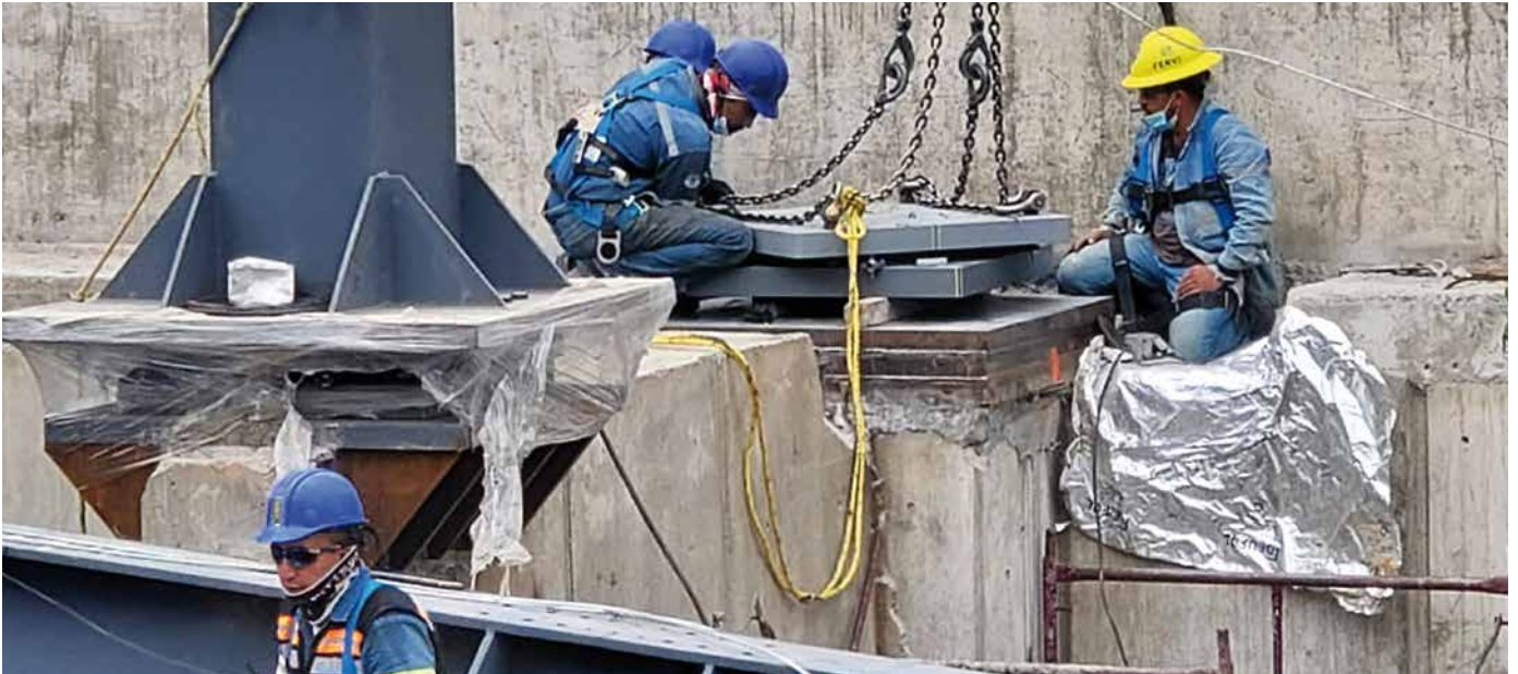
Erstmaliger Einbau der SIP®-A-Lager weltweit im August 2021. Foto: MAURER
