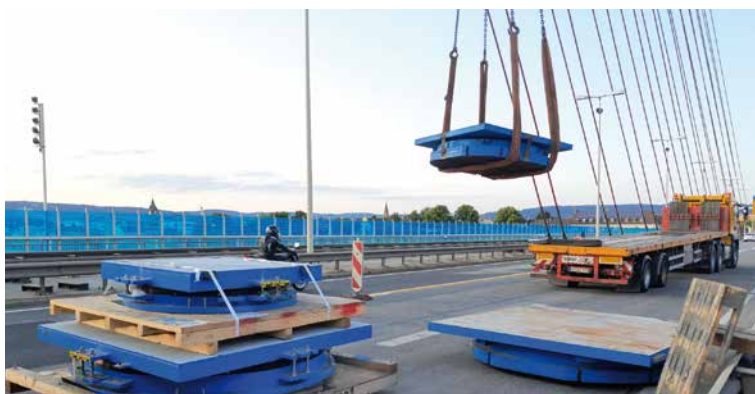
Die neuen Kalottenlager wurden von der Brückenseite aus ausgetauscht. Rechts: Eingebautes neues Kalottenlager. Fotos: MAURER
