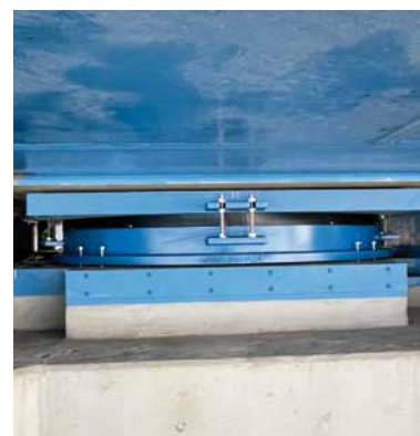
Die neuen Kalottenlager wurden von der Brückenseite aus ausgetauscht. Rechts: Eingebautes neues Kalottenlager. Fotos: MAURER
