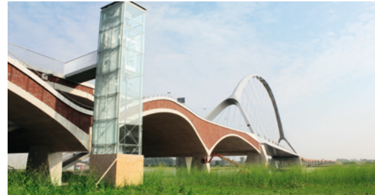
Die neue Stadsbrug in Nijmegen: Bogenbrücken im Vorland und eine Stahlbogen-Hängebrücke für das Hauptfeld.
