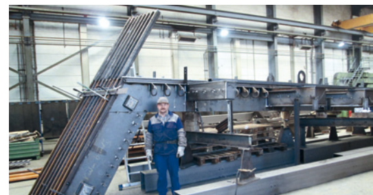
3 m hoch und am Ende wasserdicht eingeschlagen: die Gesimse der Stadsbrug in der Montage in München.
