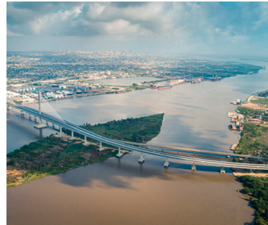
Pumarejo-Schrägseilbrücke bei Barranquilla, die längste Straßenbrücke Kolumbiens.
