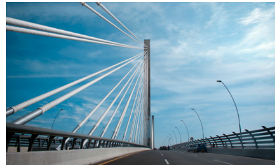
An den beiden Pylonen wirken abwechselnd Druck- und Zugkräfte.
