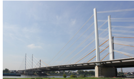
Die Rheinbrücke Neuenkamp bei Duisburg mit fertiggestelltem südlichem Überbau (vorne).
