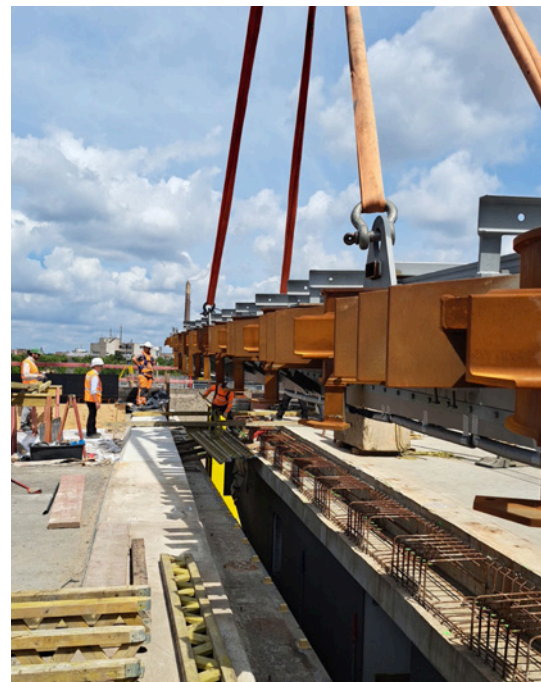
Einbau eines großen Fahrbahnübergangs im August 2023.
