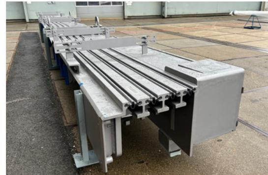
Die Sonderkonstruktion vor dem Einbau: Die linke Seite wird angeschweißt. Rechts von den Lamellen das 40 cm breite Stück, das an der nördlichen Brückenhälfte anliegen wird.
