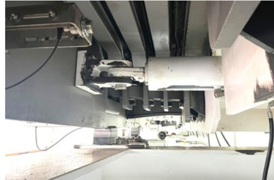
Blick unter die Sonderkonstruktion: oben grau die Lamellen, mittig quer die Hydraulik, dahinter die Schwenktraversen. Weiß ist die Stahlkonstruktion der Brücke.
