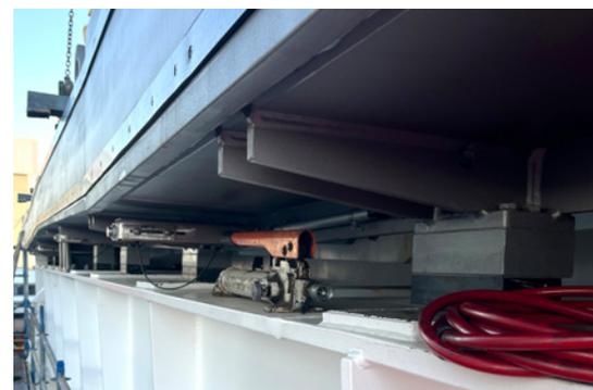
Aufgelegte Übergangskonstruktion. In geschlossenem Zustand ist sie nur leicht breiter als die weiße Stahlkonstruktion der Brücke. Oben zu sehen die beiden MSM®-Streifen, die den Druck aufnehmen, wenn die Brücke schließt.
