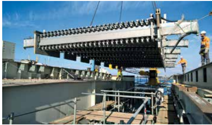
Einbau einer MAURER Modular Dehnfuge für die Izmit Bay Brücke
