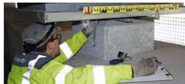
Inspektion von Brückenlagern
