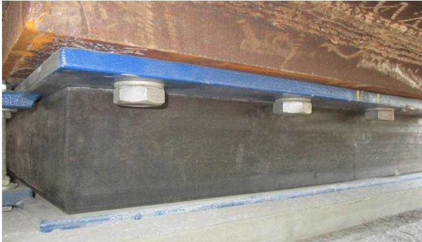
**Abbildung 15: Verguss zum Betonunterbau, Schraubenverbindung zum Stahlüberbau**
