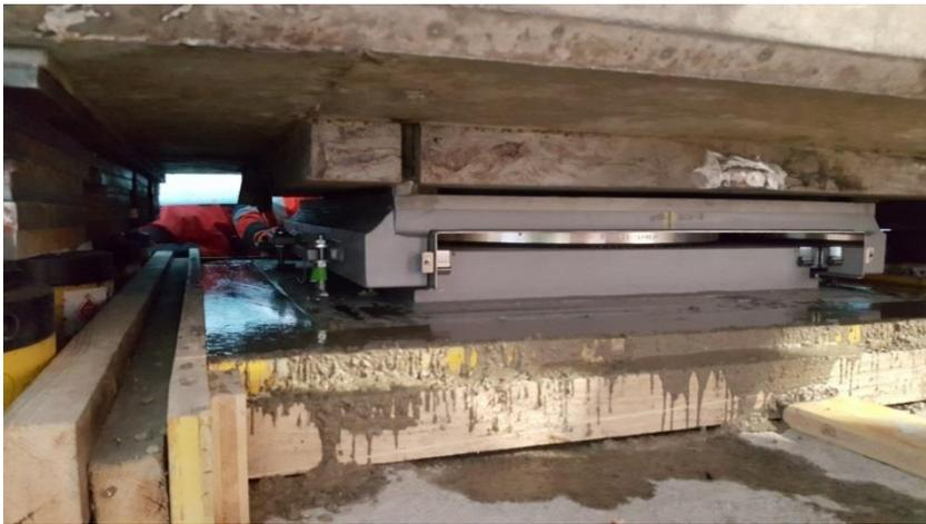
**Abbildung 13: Verguss zum Betonunterbau, Anschweißen am Stahlüberbau**
