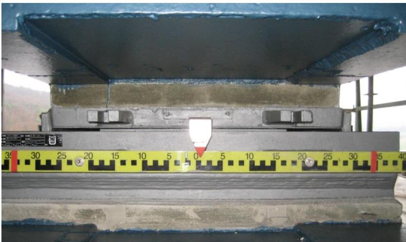
**Abbildung 14: Verguss zum Stahlunterbau, Verguss zum Stahlüberbau**
