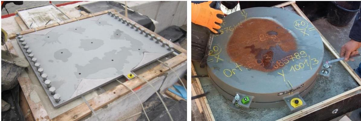
Abbildung 10: Lagerunterguss, Ankerplatte mit Luftauslassbohrungen (links) und Kalottenfestlager (rechts)
