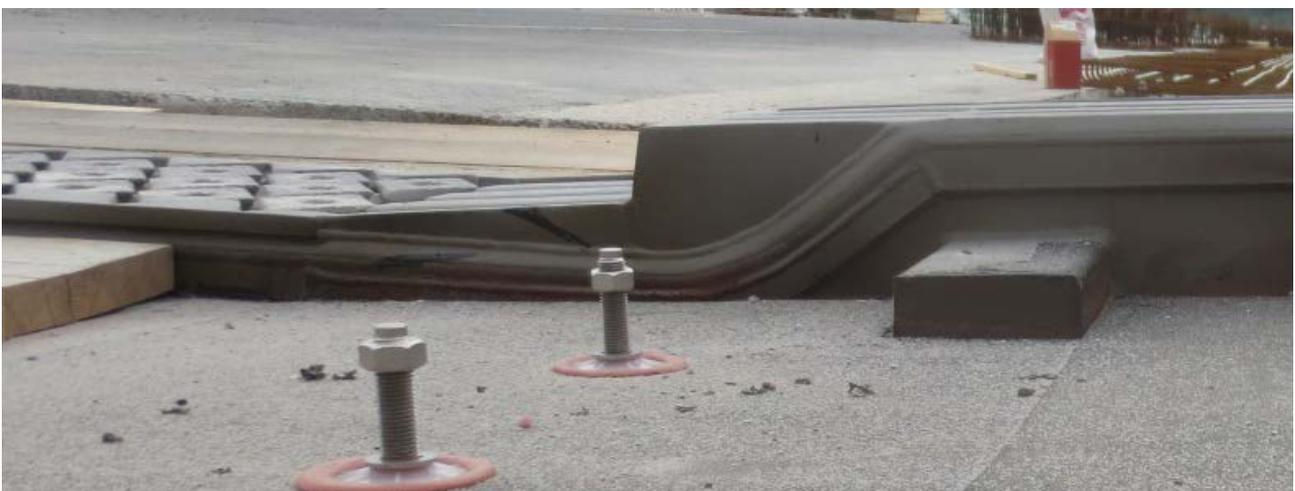
Abb. 4 - Im Tiefpunktbereich keine Schweißnähte – ungestörter Einknüpfbereich
