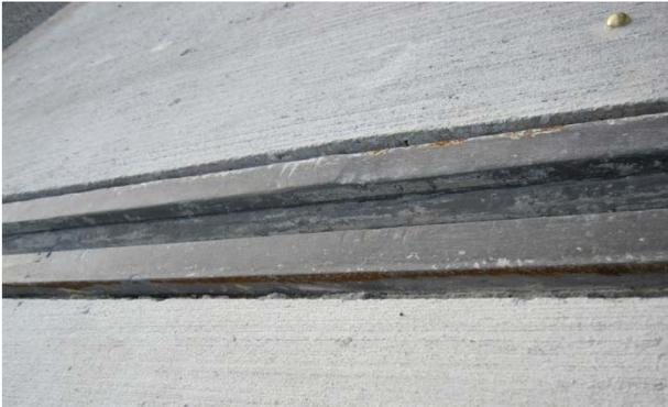
Abb. 1 - Zerstörte Beschichtung und Rostbildung noch vor Einbringen des Fugenmaterials und Inbetriebnahme
