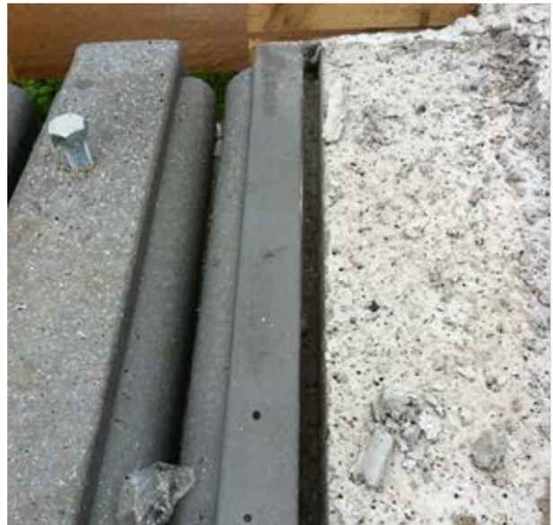
Abb. 3 - Aussparung des Kappenbetons für die dauerelastische Fuge nach Ausbau des MAURER Randprofilschutzes
