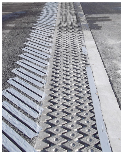
Dehnfuge XD4 mit Stützrippen und Randbalken
