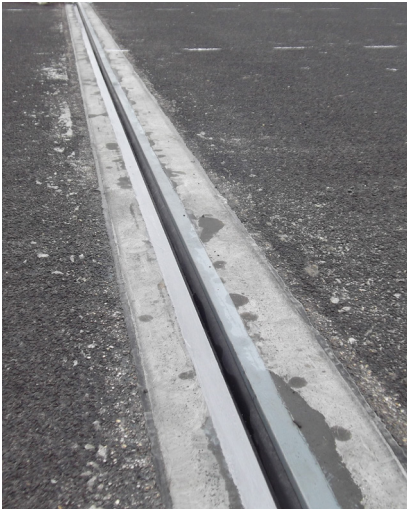
Talbrücke Großenmoor: 8 Dehnfugen D1-B (125 m)
