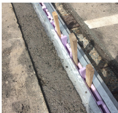
Einseitig vergossener Balken
