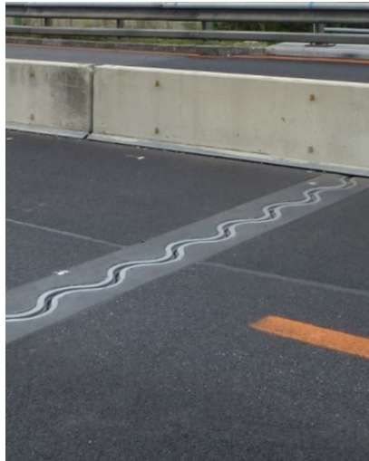
A21 Heiligenkreuz: Dehnfuge XW1 mit Randbalken
