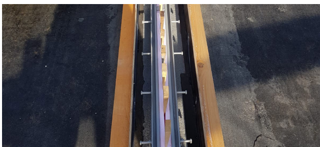
Kompakt-Dehnfuge mit Betoflex® Verankerung als Längsfuge zwischen zwei Überbauten
