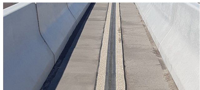
Ausführung der Längsfuge bei getrennten Überbauten
