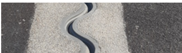
geräuschgeminderte XW1 Dehnfuge mit Polymerbetonbalken Betoflex®
