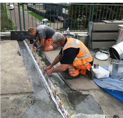
Fixieren der Spaltbreite
