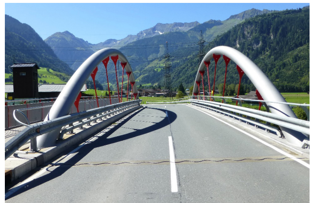
L264, Salzachbrücke Uttendorf, AT: Dehnfugen D1-B und XW1 mit Randbalken
