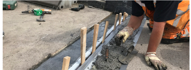
Einbau von Betoflex®
