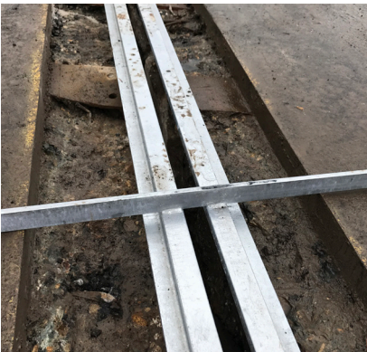
Ausrichten der Dehnfuge
