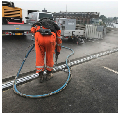
Strahlen der Anschlussflächen
