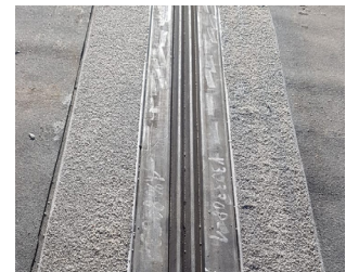
Kompaktdehnfuge mit Betoflex®
