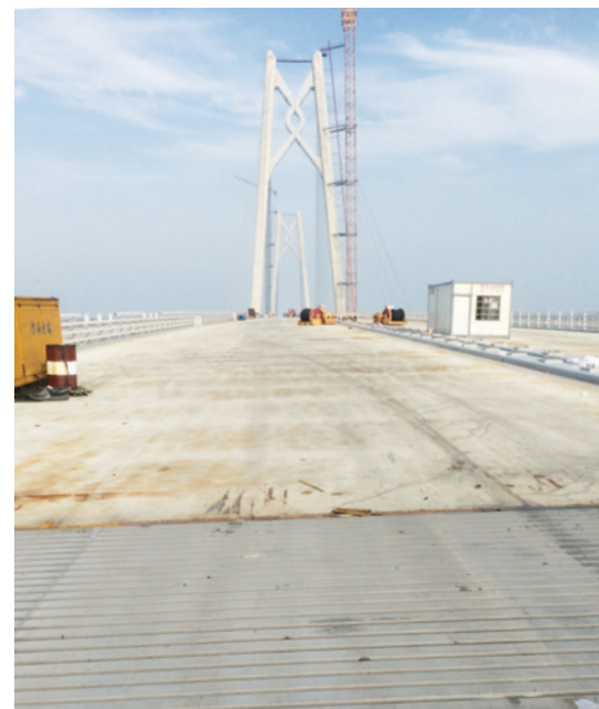
Die neuen Gleitlamellen-Dehnfugen wurden an den Hauptsegmenten der Jianghai-Schrägseilbrücke eingebaut.
