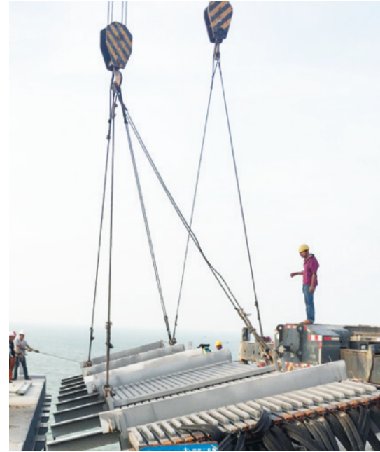
Einfädeln einer gekippten Dehnfuge in die vorgefertigten Aussparungen.
