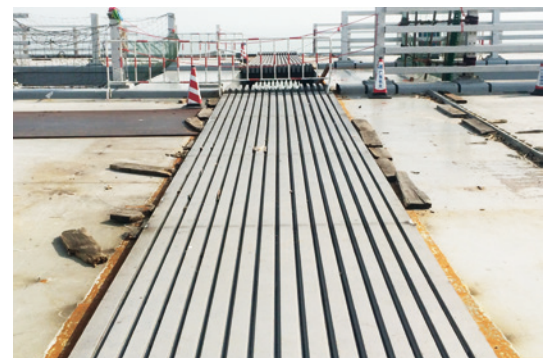
Exakt gleiche Lamellenabstände demonstrieren, wie exakt die Steuerung der Gleitlamellen-Dehnfugen funktioniert.
