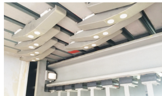
Die neu entwickelte Steuerung der Gleitlamellen-Dehnfugen.
