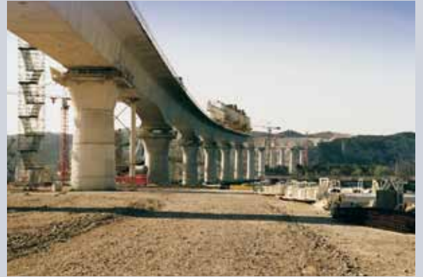
Viaduc TGV, Avignon
