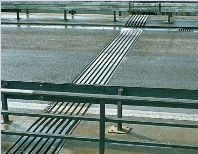
Trägerrost- Dehnfuge vom Typ D 560
