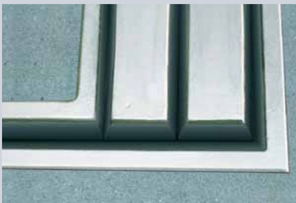
Anschluss zwischen mehrprofiliger Querfuge und einprofiliger Längsfuge
