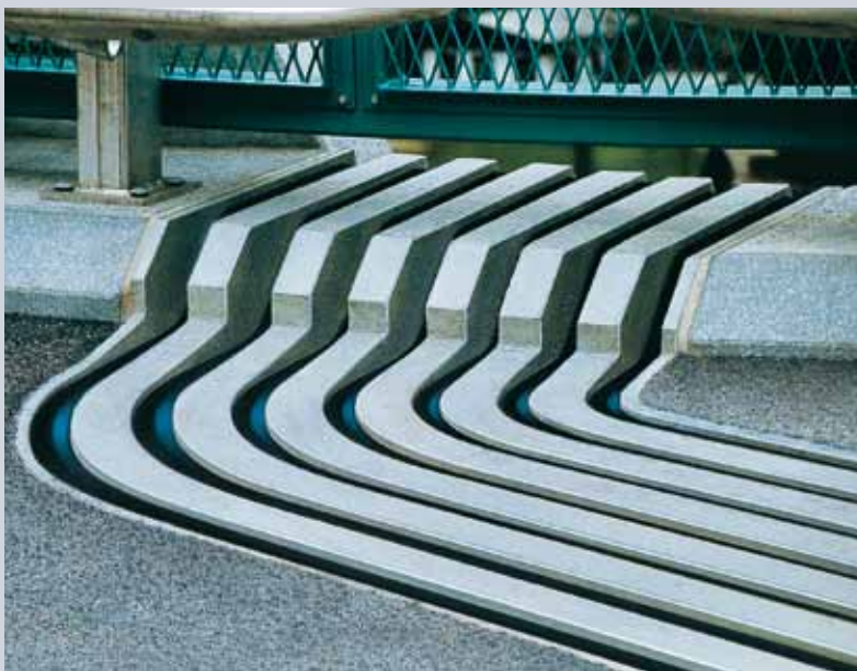
Horizontal- krümmung und Kappen- aufkantung
