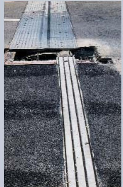
Austausch einer Rollverschluß-Konstruktion gegen eine Schwenktraversen-Dehnfuge
