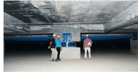
Ein SIP-Gleitpendellager und zwei horizontale adaptive Hydraulikdämpfer unter der Moschee von Algier. Die Personen verdeutlichen die Größenverhältnisse.
