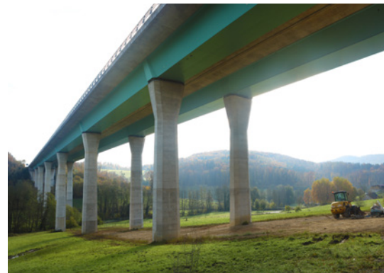
Die Dultenaugrabenbrücke zwischen Lörrach und Rheinfelden.
