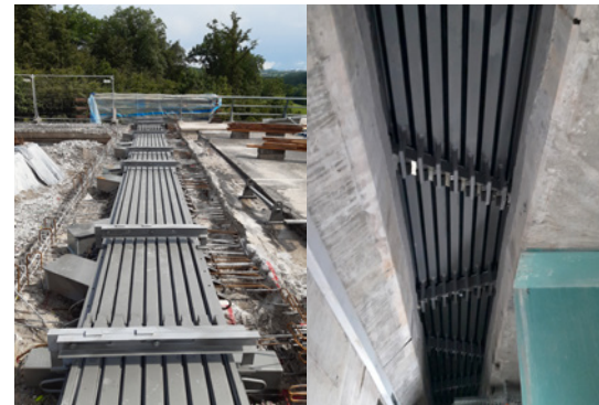
Links: Die neue MSM® Schwenktraversen-Dehnfuge beim Einbau. Sie hat eine Lebensdauer von über 100 Jahren. Rechts: Untersicht auf die neue MSM® Schwenktraversen-Dehnfuge mit den schräg angeordneten Traversen.
